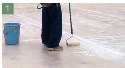
プライマー塗布
